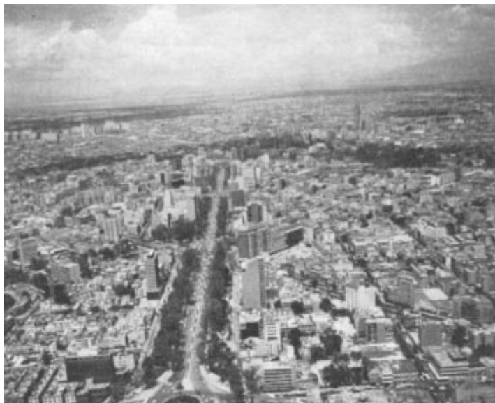
L'avenue de la Réforme.
