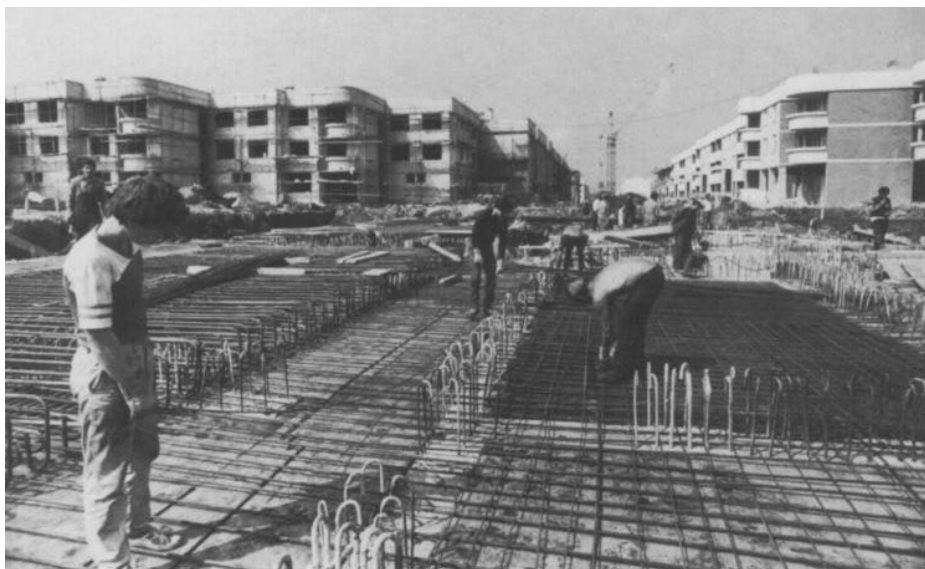
Le village olympique en chantier.
