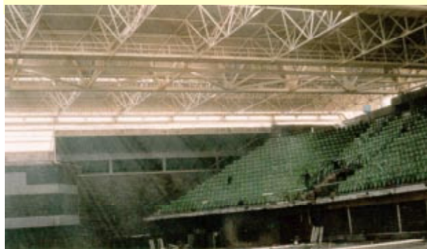
Vue intérieure de la nouvelle halle de Zetra.
