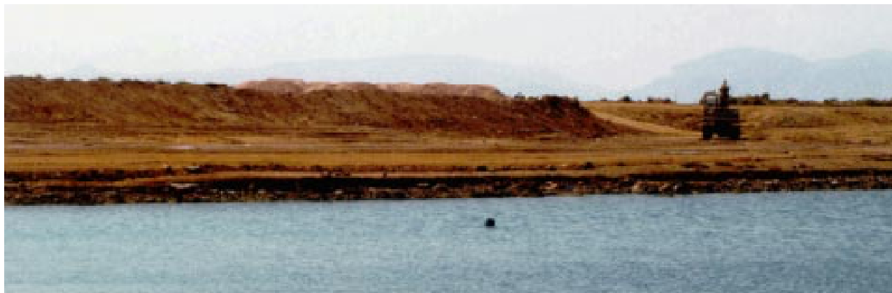
Début des travaux à Aghios Kosmas, centre nautique et marina.
